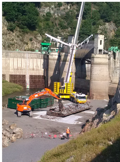
Découpage des vannes
